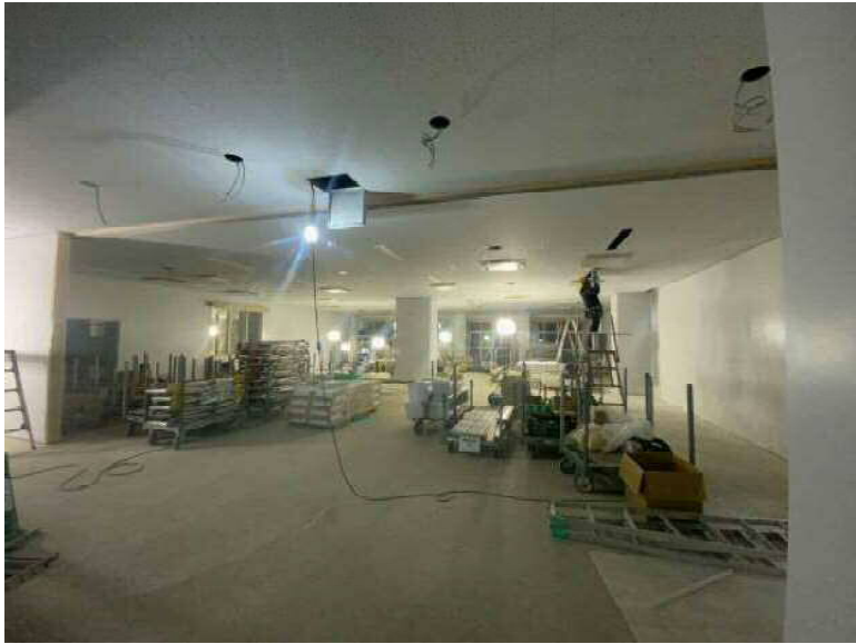
校舎棟1階ランチルーム(1)
