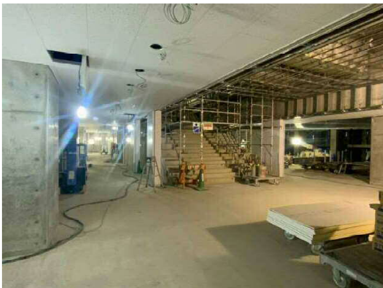
校舎棟1階南廊下
