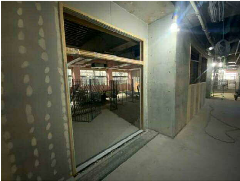
校舎棟4階美術室
