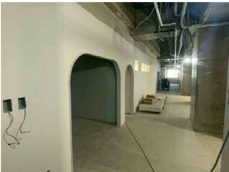
校舎棟3階北廊下
