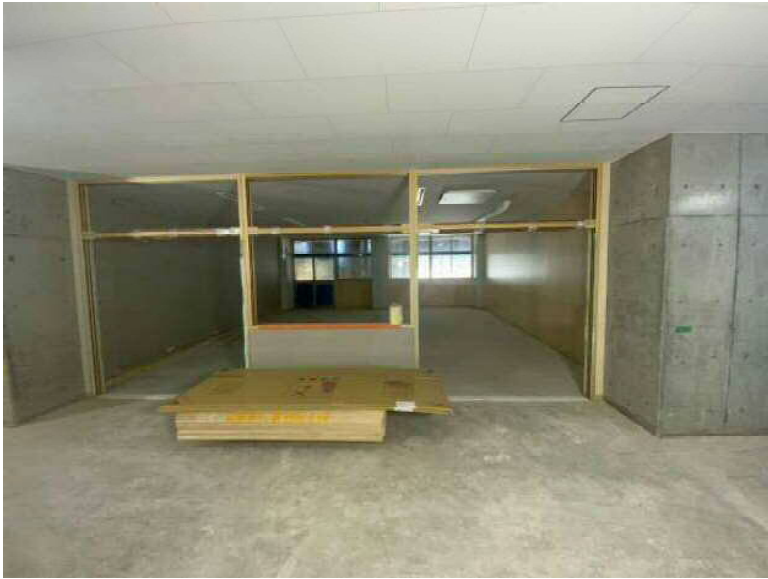
校舎棟2階普通教室
