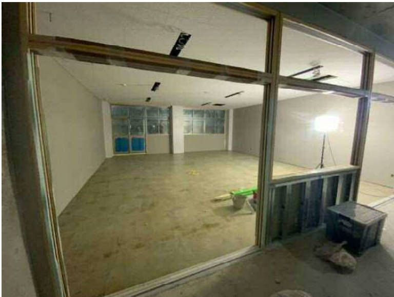
校舎棟3階普通教室
